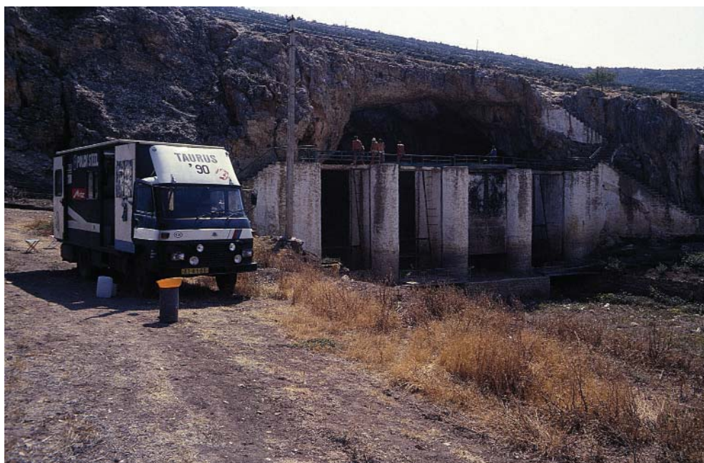
Mohutný ponor Karagöl Düdeni je obrovitý hltáč vody odvodňující celou plochu polje. Ústí jeskyně s překrásným přírodním mostem je přehrazeno betonovou hrází s propustmi.
