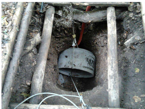
2e/ Osazování první (spodní) skruže; 17.10.2015.
