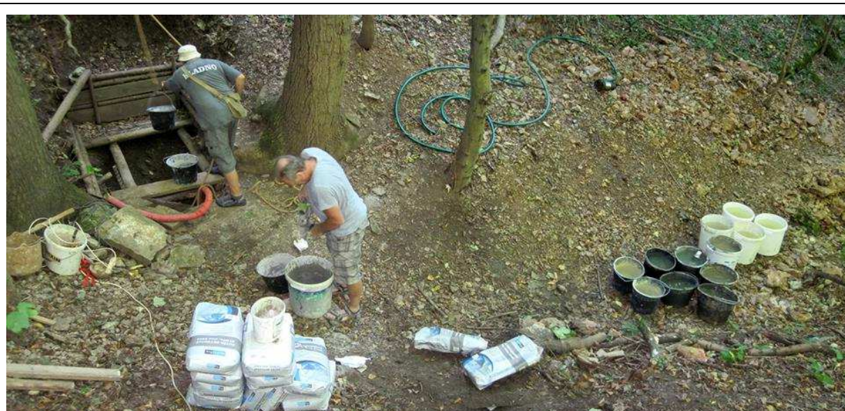
1e/ Betonáž stropu jeskyně, který ponese skruže.
