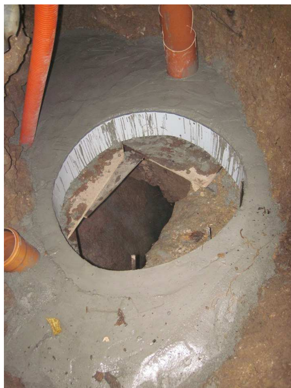
2i/ Čerstvě vybetonovaný strop s otvorem pro usazení skruží. V betonu instalováno odvětrání jeskyně, potrubí na odvod čerpané vody a kabelová průchodka; 5.9.2015.
