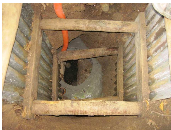
2d/ Vybetonovaný strop s otvorem pro skruže; 5.9.2015.
