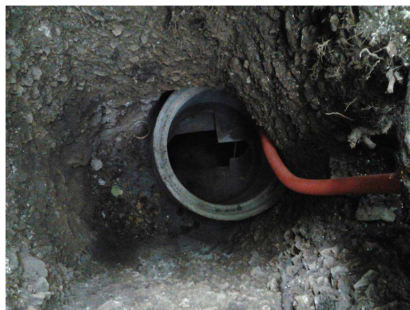
2f/ První skruž zabetonována; 17.10.2015.
