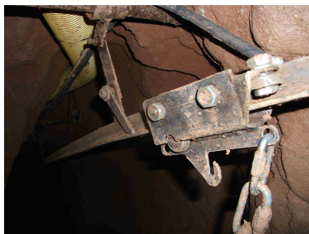
2m/ Detail běhounu alvekové lanové dráhy.
